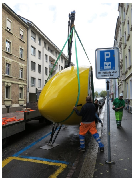
Abb.2 : 5m Arbeitsraum in die Höhe wg. Kran notwendig.
