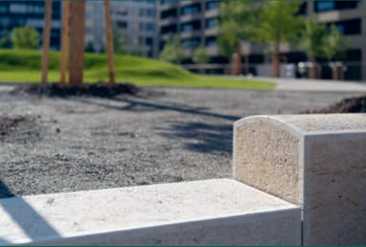
Natursteinmauern und Tritte aus Kalkstein bilden einen schützenden Rahmen gegen die Strassen.
