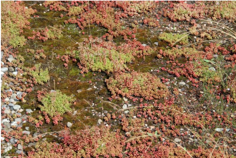
Vor der Aufwertung mit 9 cm Substrat
